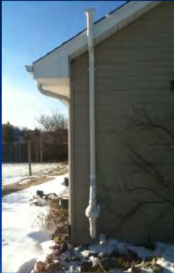
Proper exterior riser pipe
